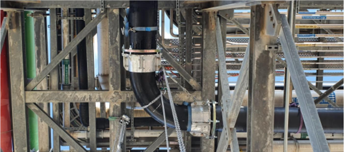
Sustitución de tuberías de HDPE por PE-X para el transporte de agua industrial tratada.
